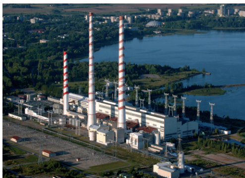
6.3 pav. Lietuvos elektrinė
