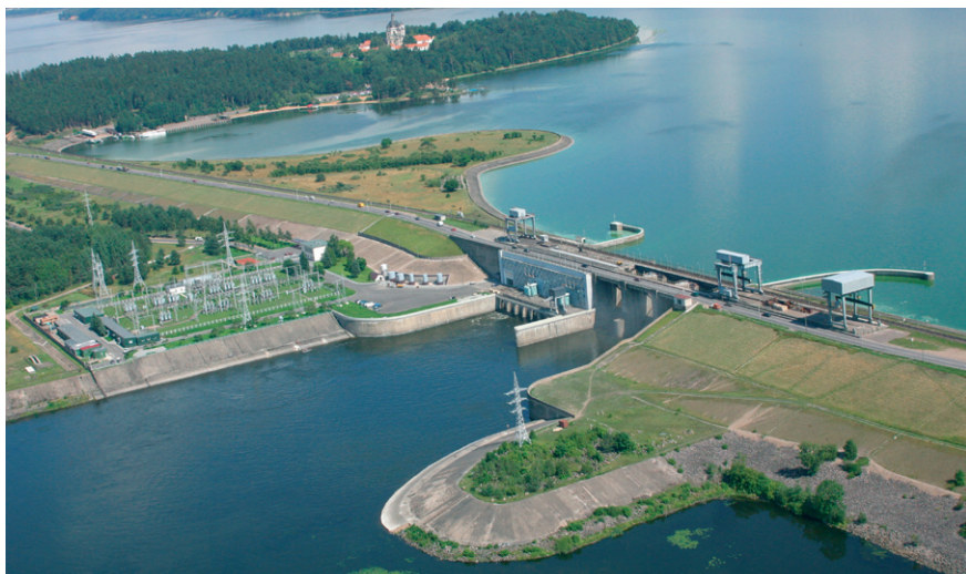
6.9 pav. Kauno hidroelektrinės bendras vaizdas
