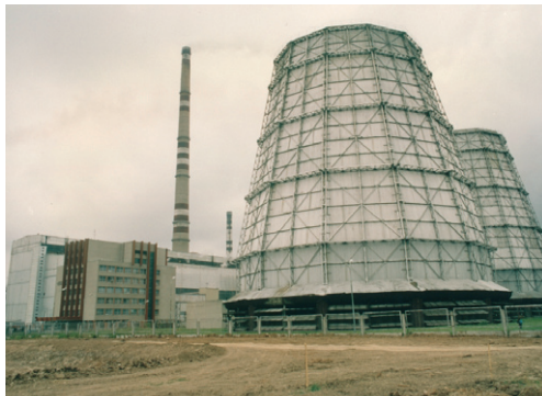
6.6 pav. Mažeikių termofikacinė elektrinė
