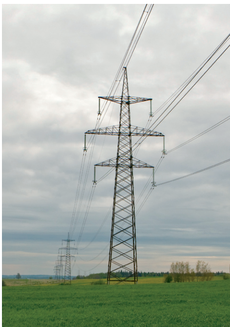
4.2 pav. Elektros linija su dviejų laidų fazėmis
