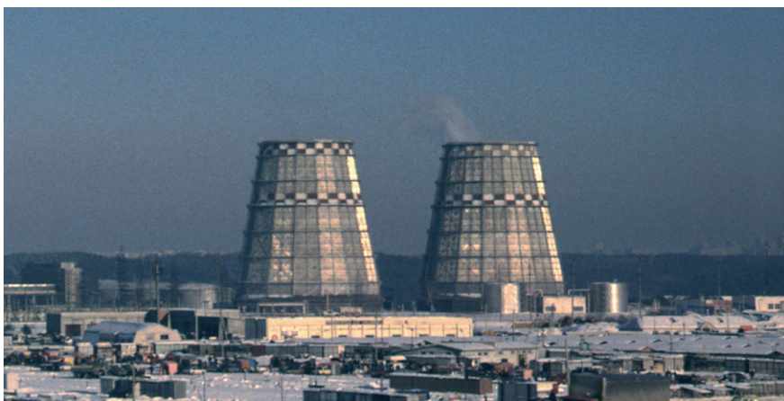
2.5 pav. Vilniaus termofkacinės elektrinės aušinimo bokštai
