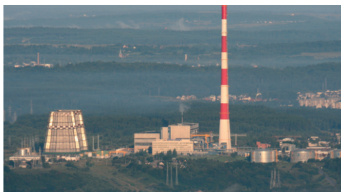
6.4 pav. Vilniaus termofikacinė elektrinė TE-3
