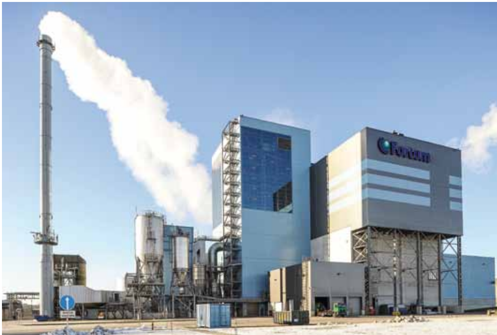
Atliekų deginimo „Fortum Klaipėda“ termofikacinė elektrinė
