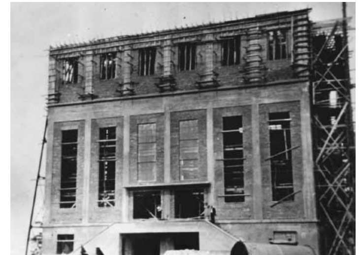
Rėkyvos elektrinės statyba, 1939 m.
