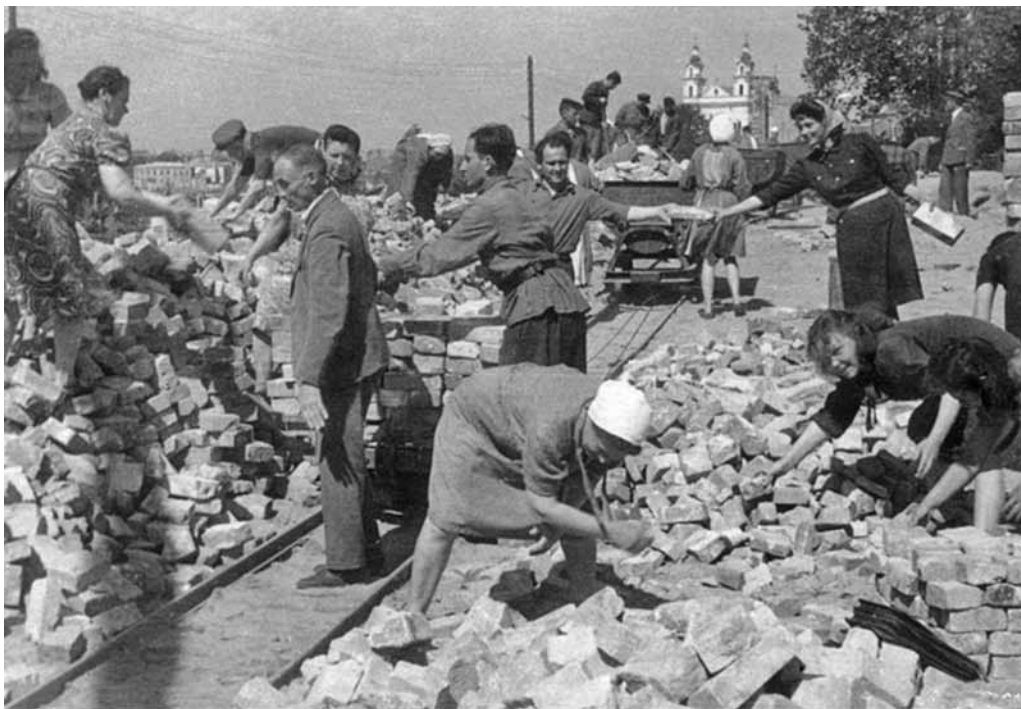
Vilniaus centrinės elektrinės atstatymo darbai, 1944-08-20
