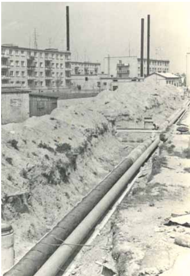
Naujos šiluminės trasos statyba. Priekyje – kvartalinė katilinė (1963 m.)
