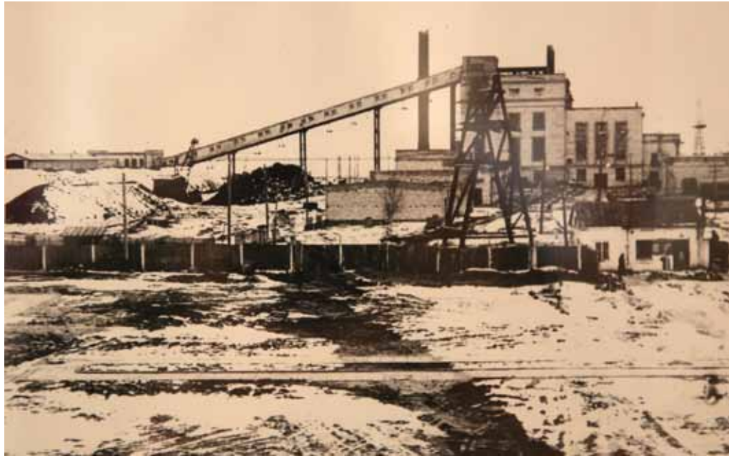
Elektrinė 1955 m. Baigtas išplėtimas, pastatyta kuro padavimo estakada, žemės paviršiuje matyti šiluminės trasos pėdsakas
