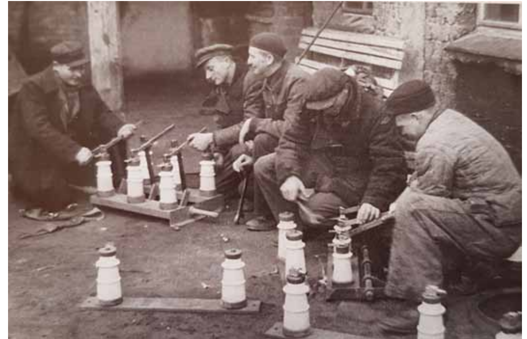
Elektrikai montuoja skyriklį iš keleto sudaužytų, 1945 m.
