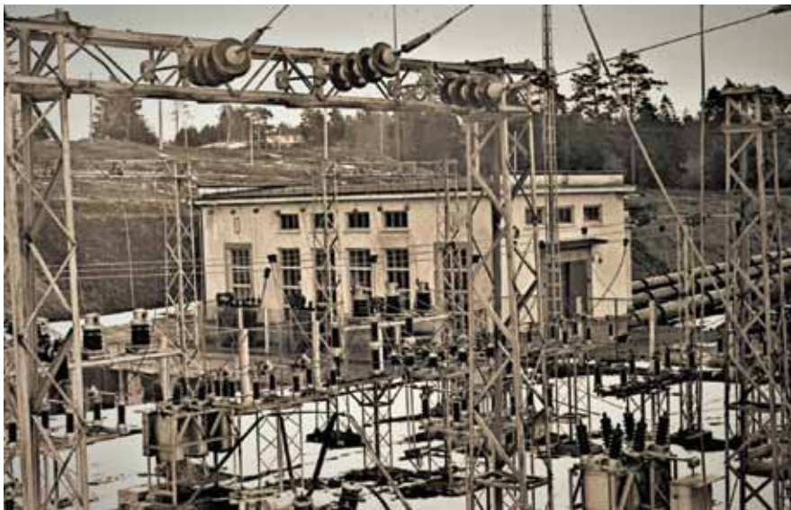
Antalieptės hidroelektrinės 35 kV skirstykla, 1959-12-20
