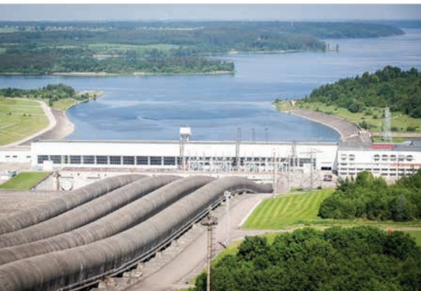
Kruonio HAE pagrindinis pastatas, toliau vandens pūmtuvo kanalas
