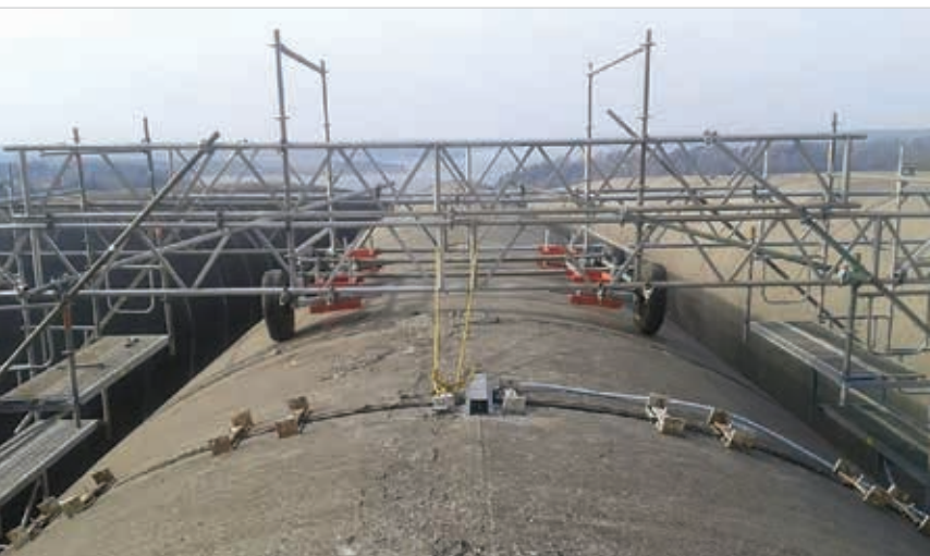
7,5 m diametro gelžbetoninio vamzdžio montavimas
