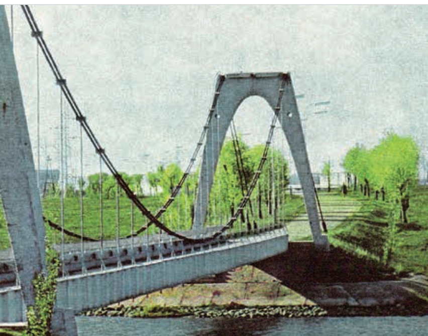
70 metrų ilgio kabantis pėsčiųjų tiltas per įtekanti į Elektrėnų marias upelį jungia VRE teritoriją su energetikų gyvenvieta
