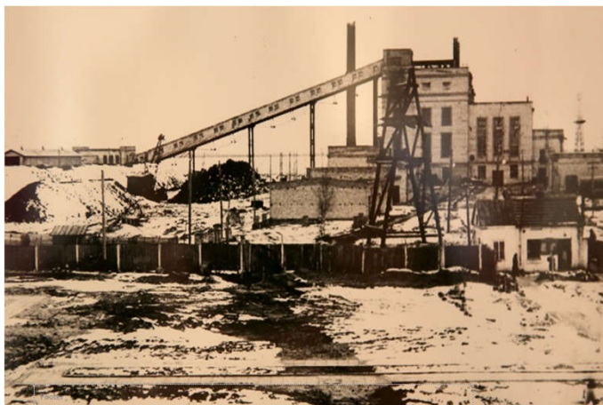
Elektrinė 1955m. Baigtas išplėtimas, pastatyta kuro padavimo estakada, žemės paviršiuje matyti šiluminės trasos pėdsakas
