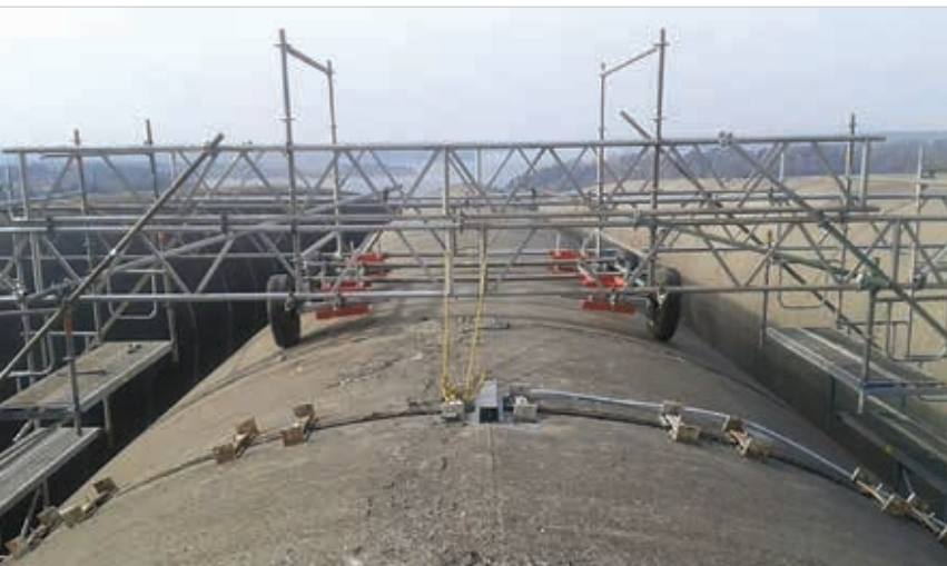
7,5 m diametro gelžbetoninio vamzdžio montavimas
