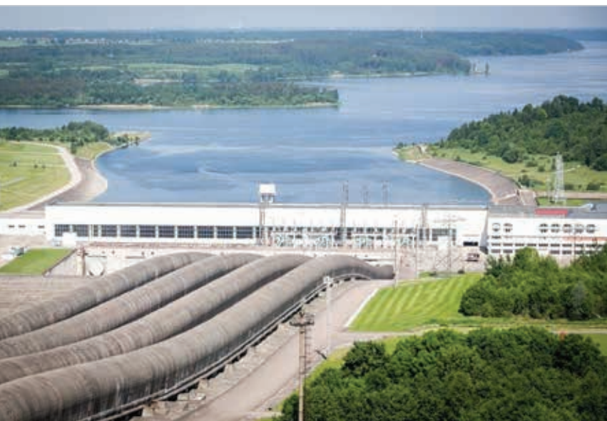
Kruonio HAE pagrindinis pastatas, toliau – vandens piimtuvo kanalas
