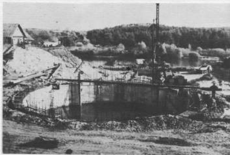
57 pav. Kojama Vilniaus trečiosios termofikacinės elektrinės (Vilniaus TE-3) pamatų plokštė (1981.09.16)
