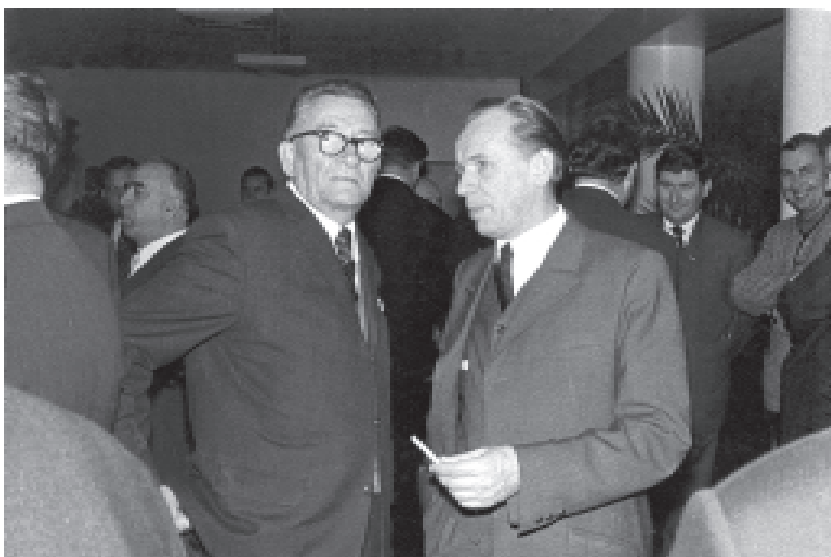
Su TSRS energetikos ir elektrifikacijos ministerijos Šiaurės vakarų vyr. valdybos viršininku G. Kotilevskiu paleidus Lietuvos elektrinės 8-ąjį bloką ir pasiekus 1800 MW galią, 1972 m.
