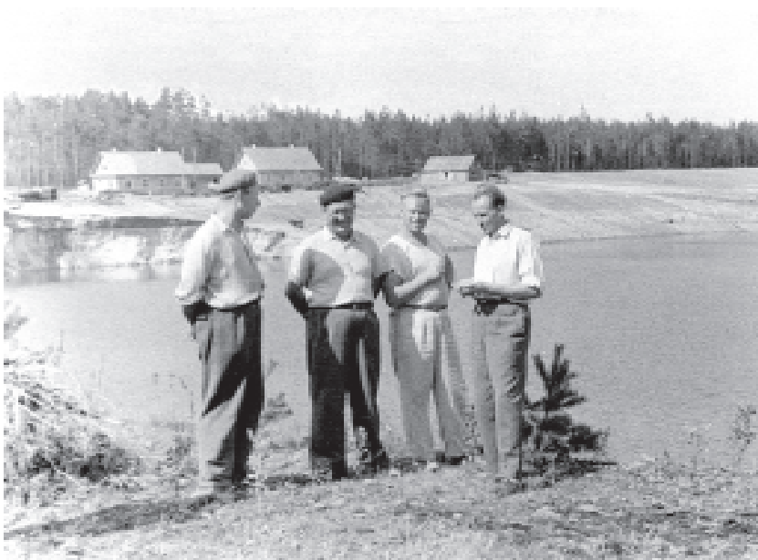
Baltosios Ančios hidroelektrinę atstatant, 1959 m. Iš kairės: vyr. darbų vykdytojas J. Čiras, Anykščių SMV viršininkas T. Bitinas, Hidrotechninės tarnybos inžinierius J. Nekrašas ir LŪT Energetikos ūkio valdybos viršininko pavaduotojas A. Stumbras
