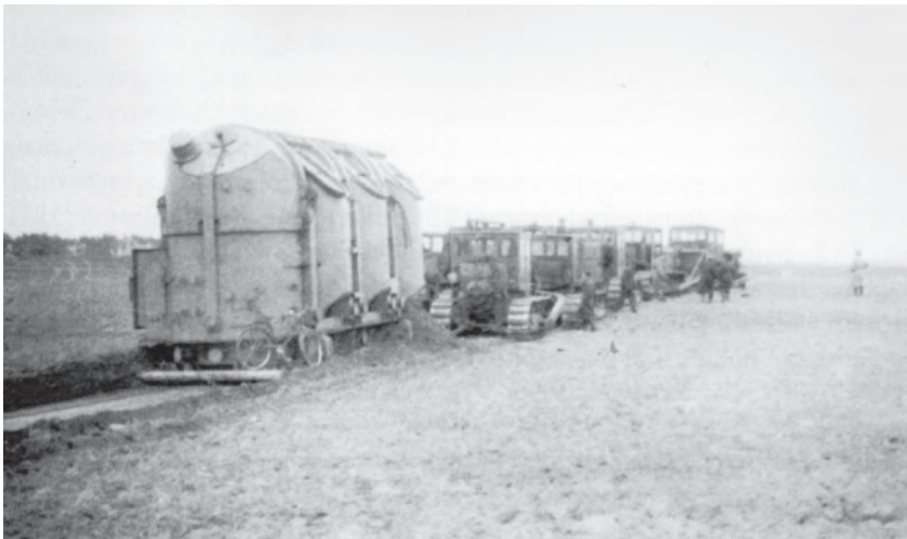
Autotransformatoriaus „kelionė“ į 330 kV įtampos Vilniaus pastotės statybos aikštelę
