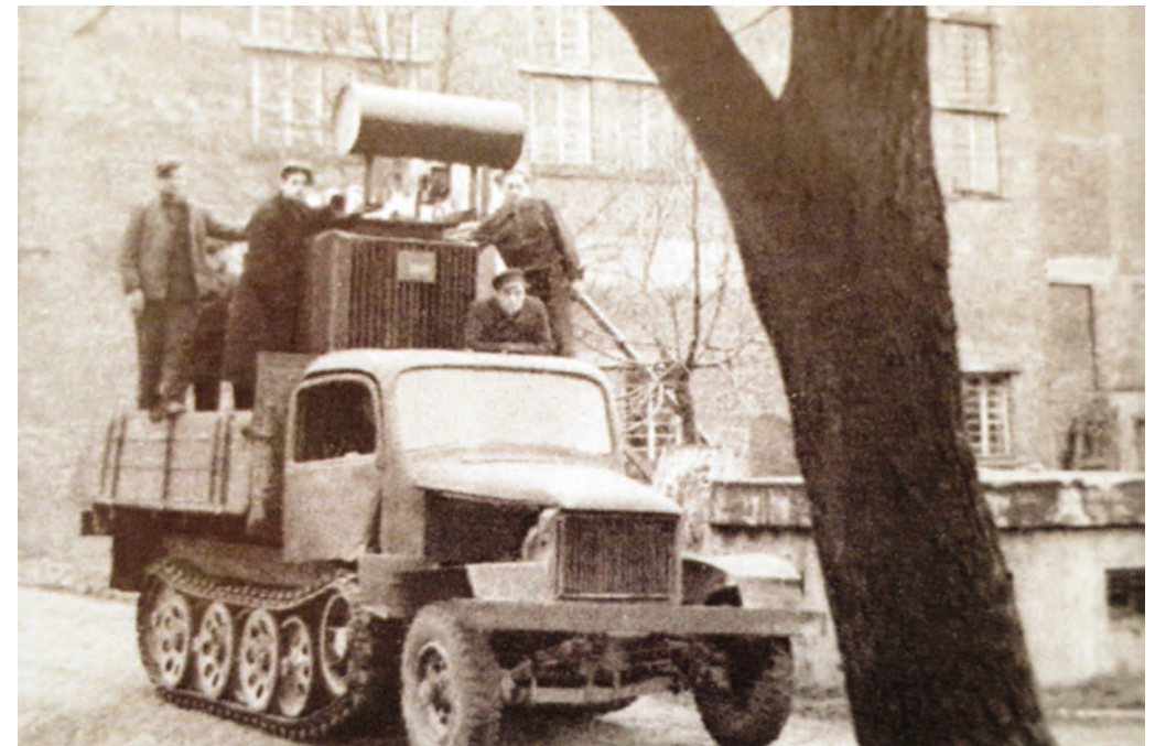
Atstatant Klaipėdos elektrinę naudotas Karaliaučiuje gautas trofėjinis sunkvežimis
