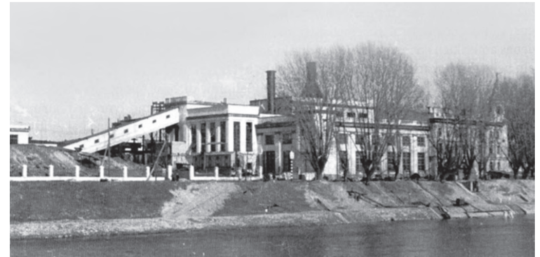
Visiškai atstatyta Vilniaus pirmoji (centrinė) elektrinė 1948 m.
