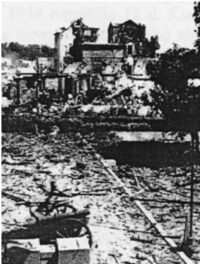
1944 07 30 susprogdintos Kauno dyzelinės elektrinės vaizdas
