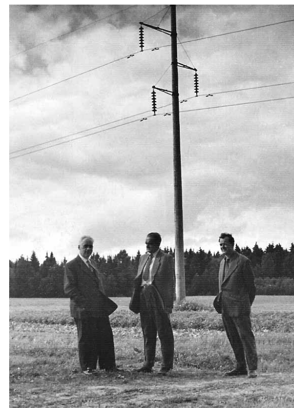
1-oji 110 kV linija su gelžbetoninėmis atramomis
